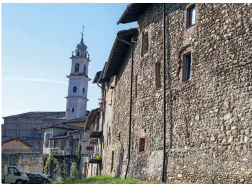
Fig. 3. Fronte delle mura difensive settentrionali del Borgo Mezzano di Dronero.
